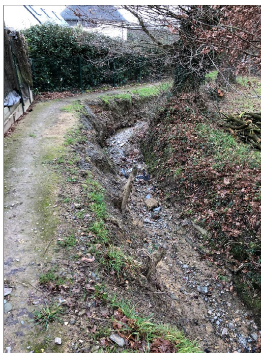
Photographie fossé exutoire (proximité des habitations)
